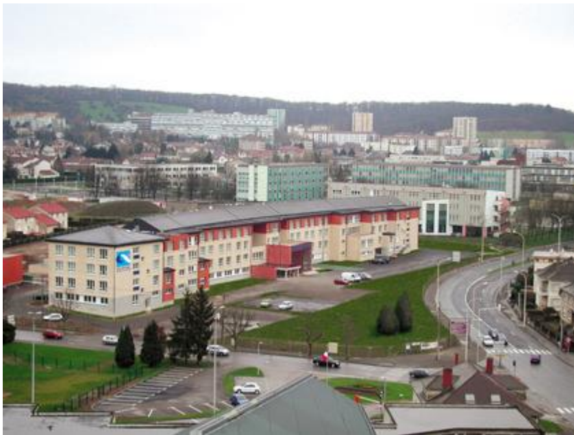
Figure 8 : Photo de l'hôpital Le Kem
